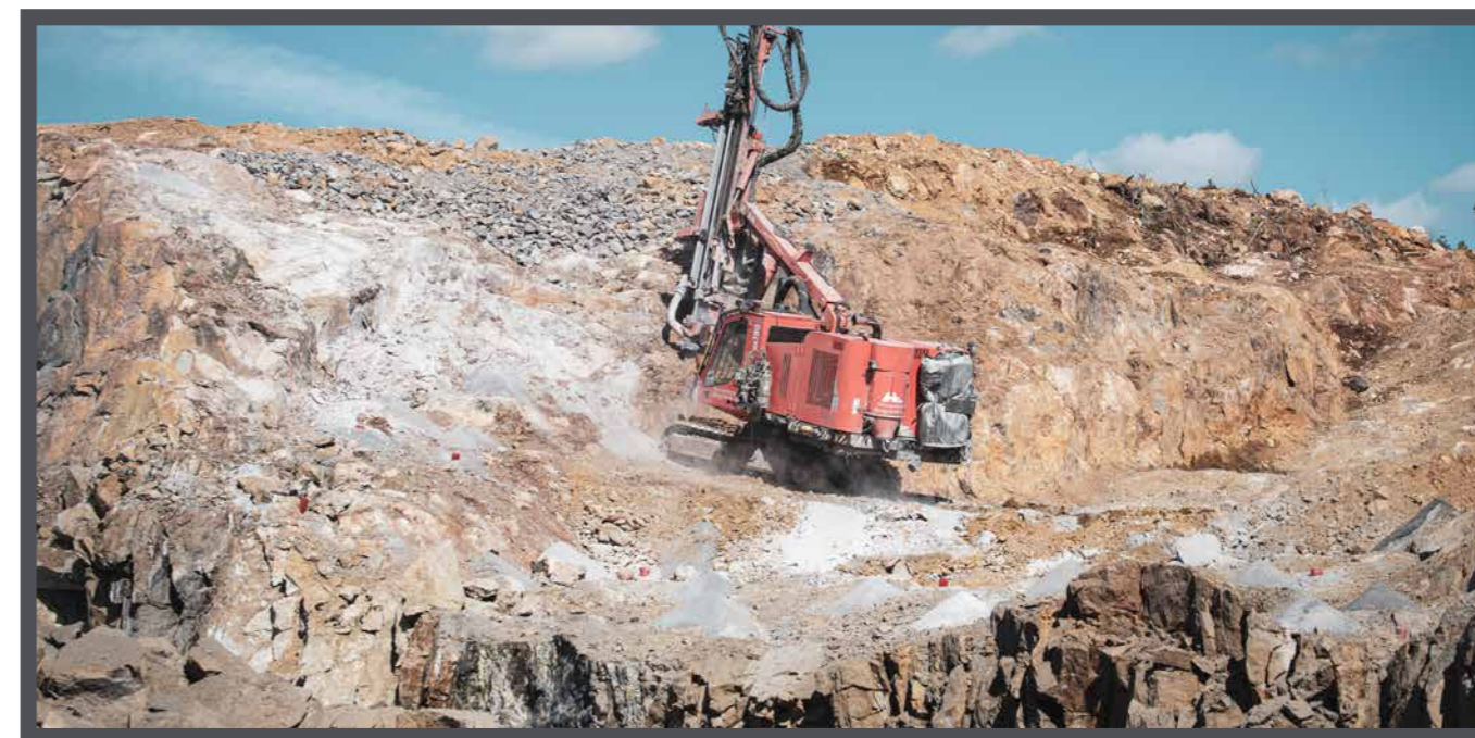
Pegrocoss portföljbolag Nordisk Bergteknik och dess dotterbolag Norrbottens Bergteknik under arbetet med bergsbörning på Markbygdens vindkraftspark
