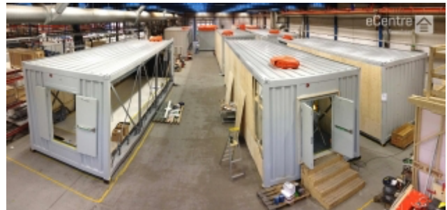
Produktion i Vara i Västergötland av eCentre, en världsledande produkt på den snabbväxande marknaden för prefabricerade modulära datacenter, hos Flexenclosure, ett av bolagen i Pegrocos Tillväxtportfölj.
